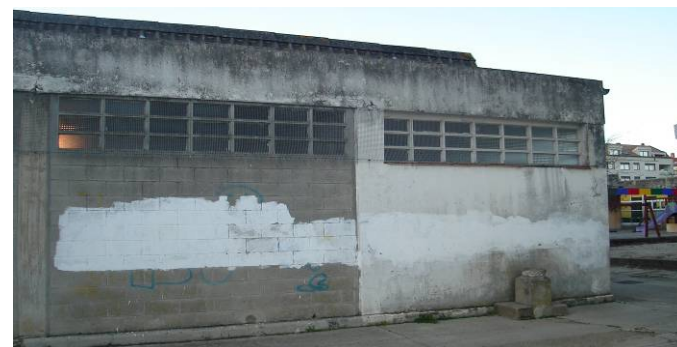
Imaxe das paredes exteriores do patio cuberto
